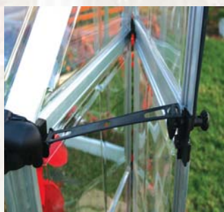
Ruční zajištění dveří a dělený dveřní zámek
